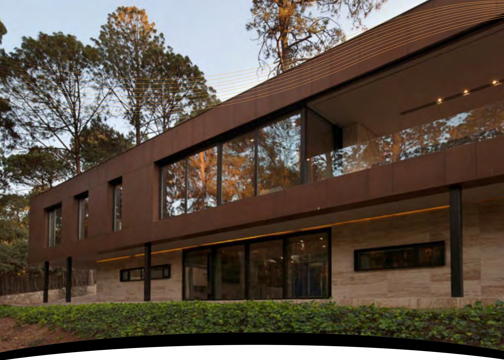
VALLE DE BRAVO: Construcción de Complejo Residencial Fase 2 de 2,500 m2 Valle de Bravo, Edo. De Mexico
