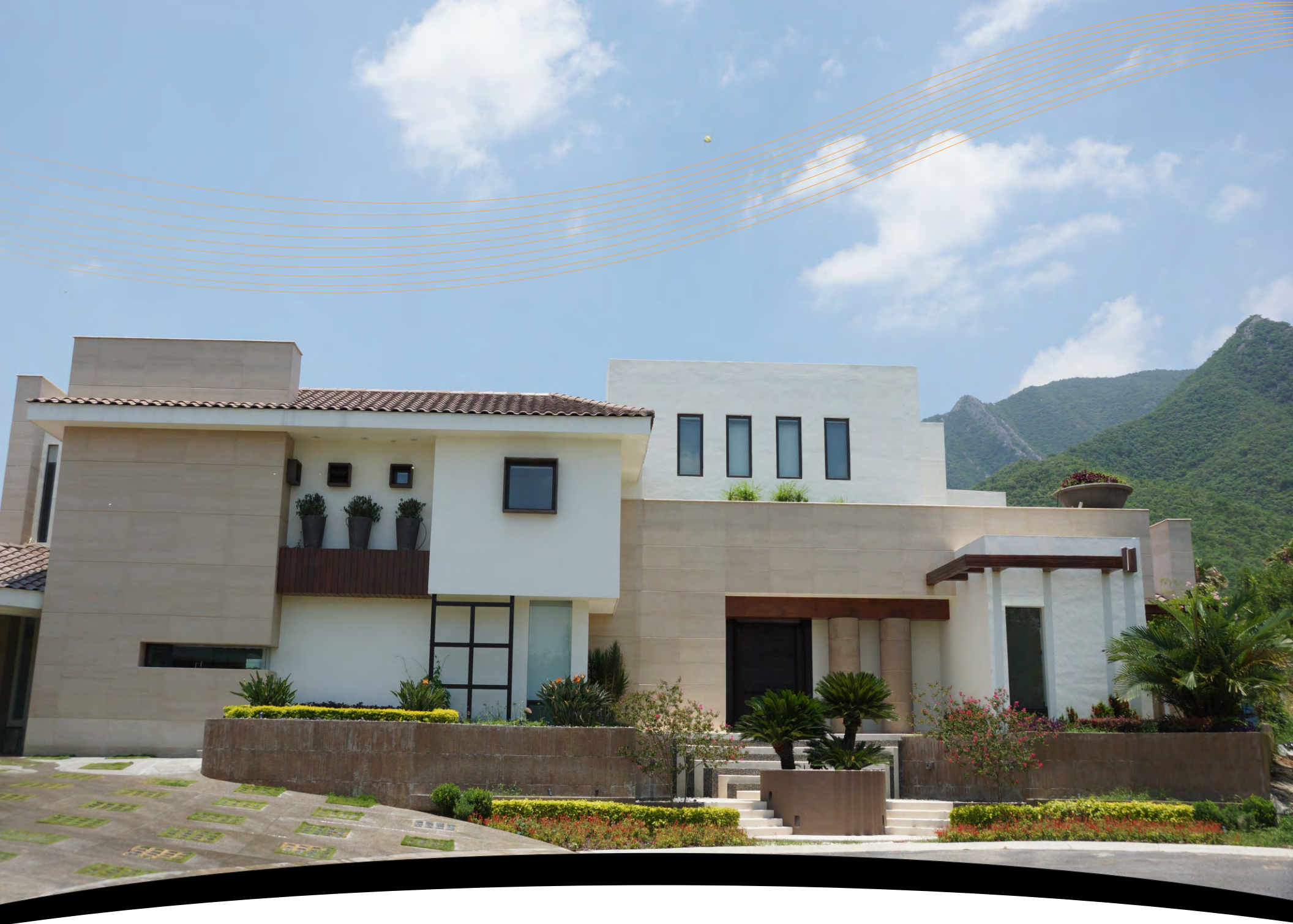
MONTERREY, N.L.: Construcción de Complejo Residencial.
