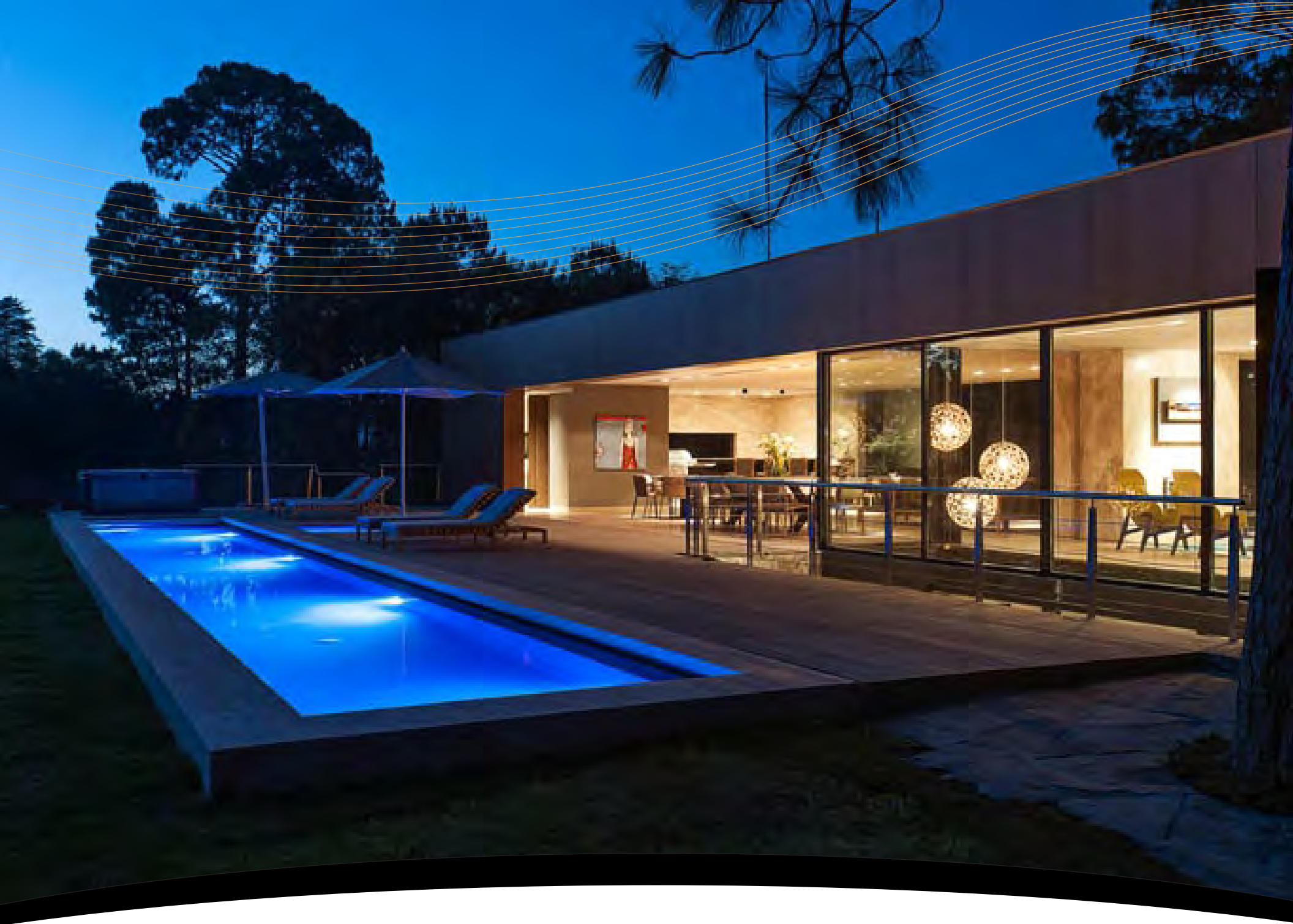
VALLE DE BRAVO: Construcción de Complejo Residencial de 2,500 m2 Valle de Bravo, Edo. De Mexico
