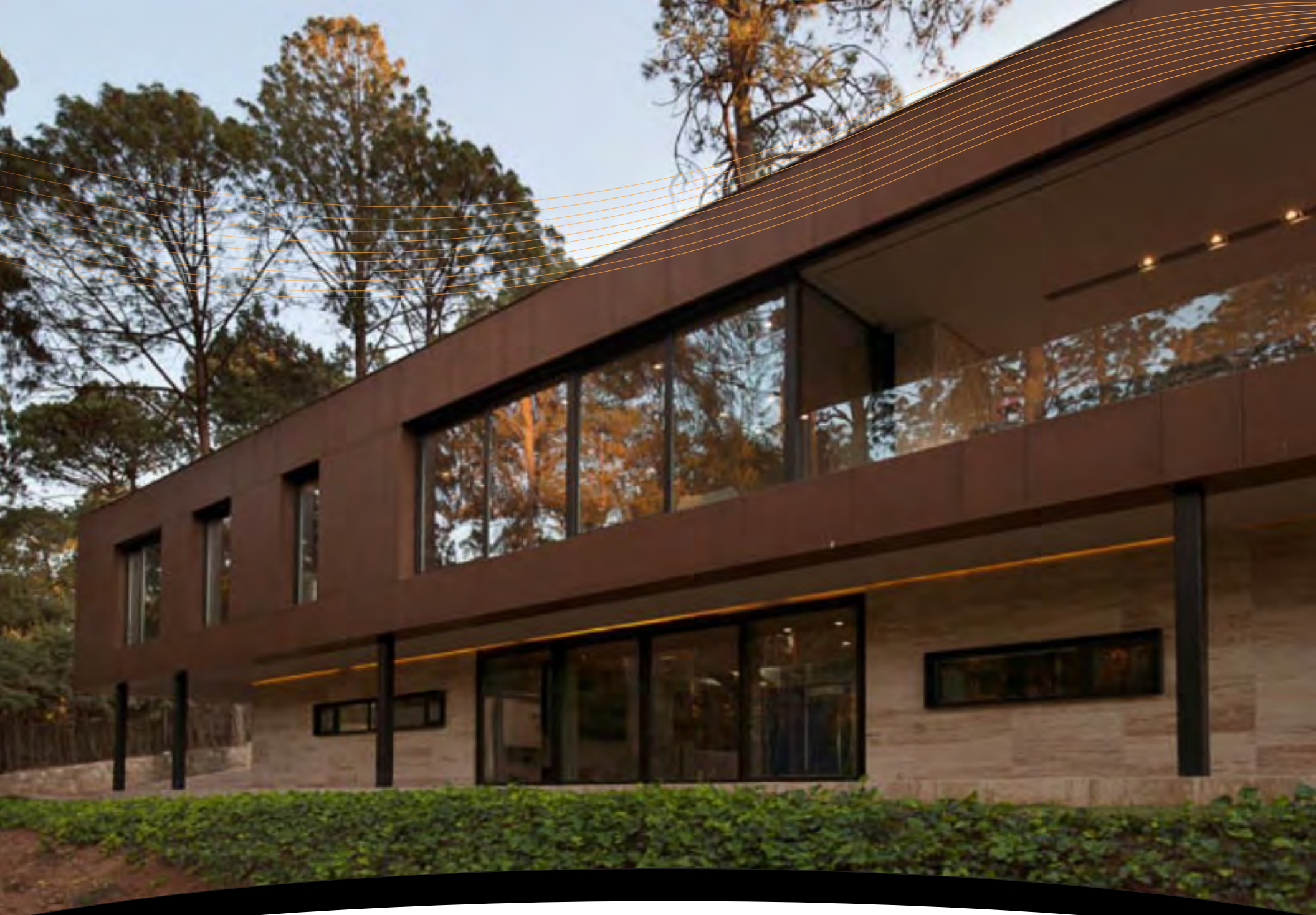
VALLE DE BRAVO: Construcción de Complejo Residencial Fase 2 de 2,500 m2 Valle de Bravo, Edo. De Mexico
